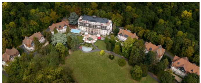
Figure 26 Vue d'ensemble du Falkenstein Sanatorium © Falkenstein Grand Königstein
