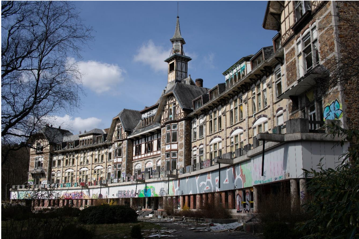
Figure 1 Vue de la Façade Sud. © Photo personnelle
