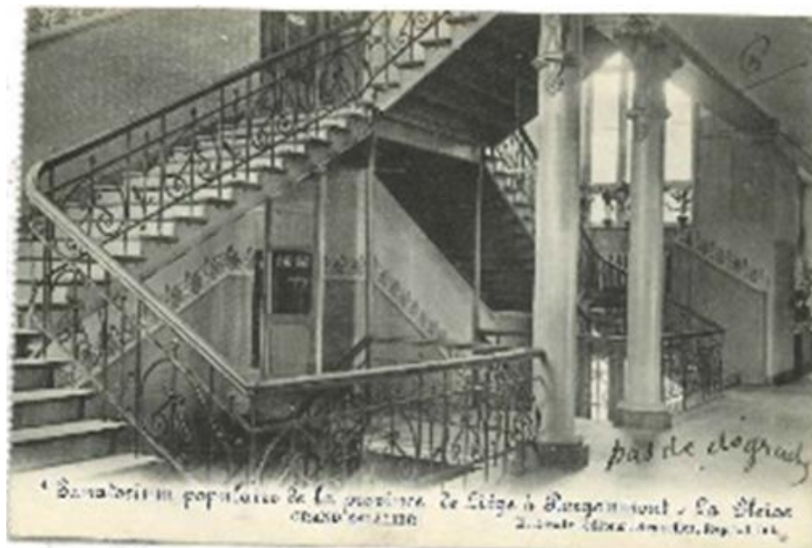
Figure 24 L'escalier central. © E. Dessaix
