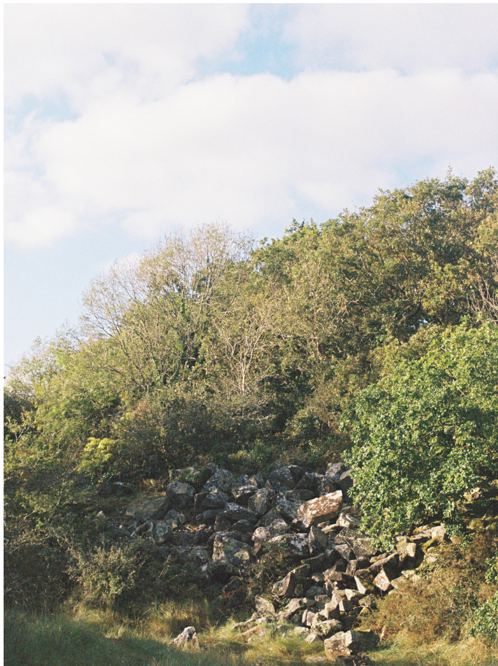
Remblais de déchets de pierre
