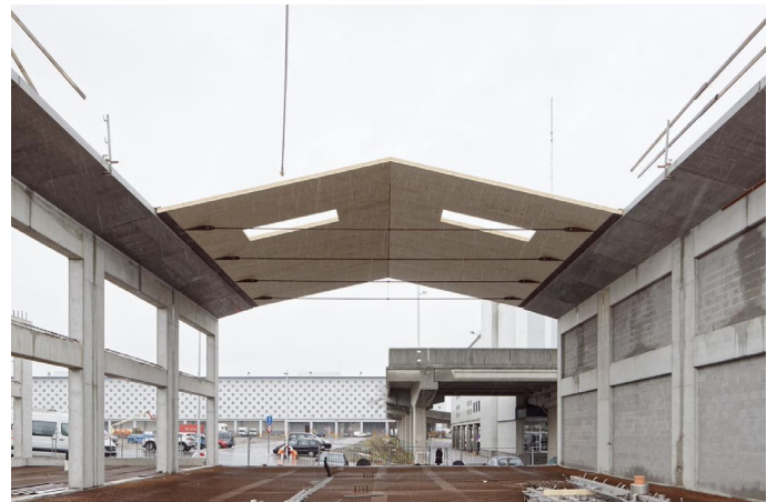
fig2...placement des toitures sur la structure / photo officielle Generale.la
