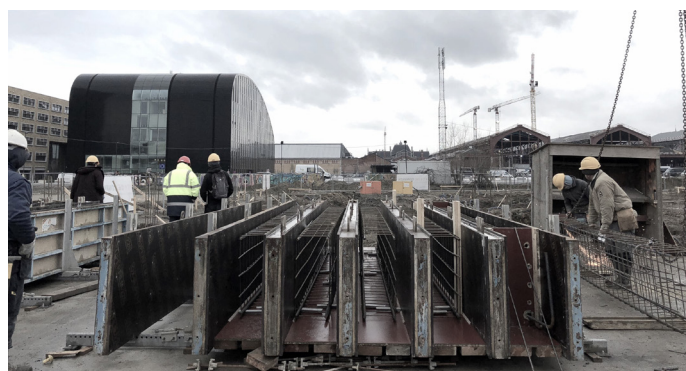
fig.3_coffrage des colonnes / photo officielle Generale.la
